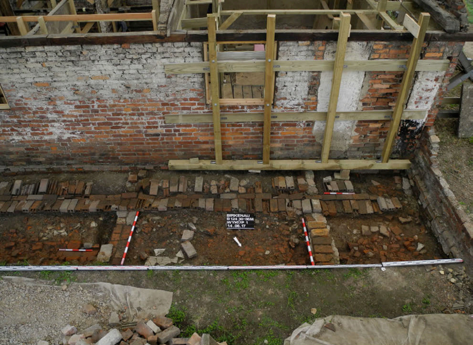
Fundamenty nieistniejącego budynku przy północnej ścianie baraku B-124, po stronie zachodniej dziedzińca wraz z fragmentem późniejszego rynsztoka. Fot. M. Mazurkiewicz
