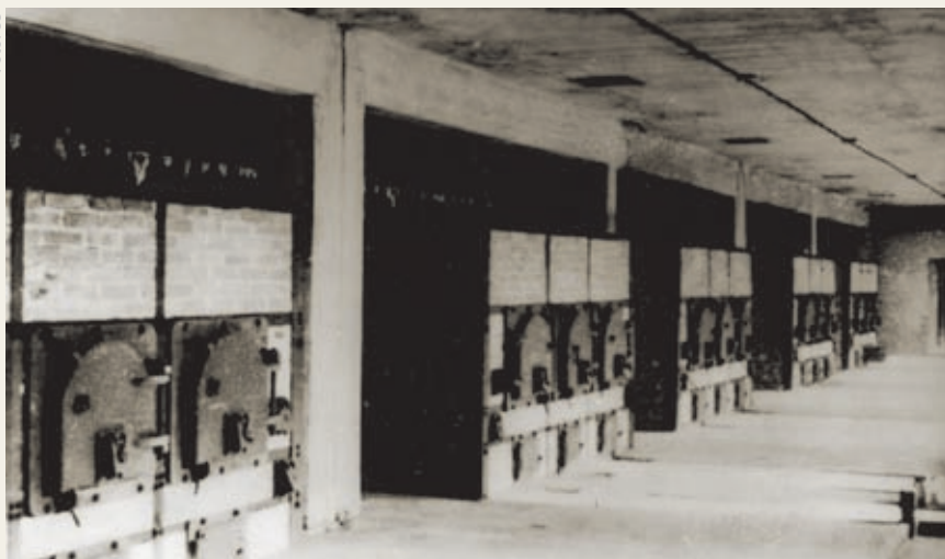
Kemencék a gázkamra és II. sz. krematórium épületében Birkenauban.
