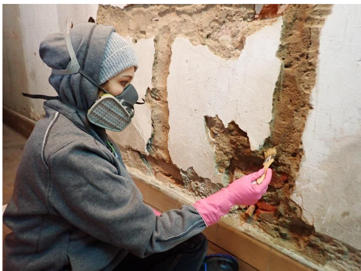
Fot.4. Zabezpieczenie tynku (fot. J. Krasowska)
