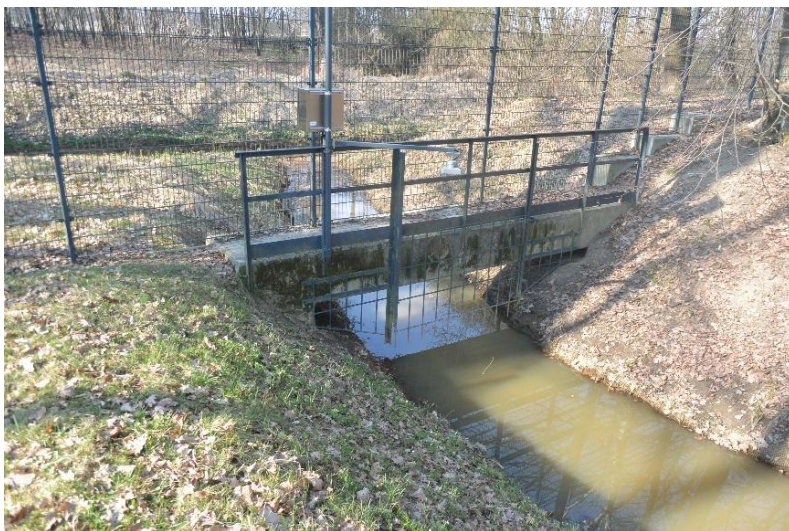
Fot. 8. Stacja monitoringu poziomu wód powierzchniowych (fot. A. Jeszke-Tymkowska)
