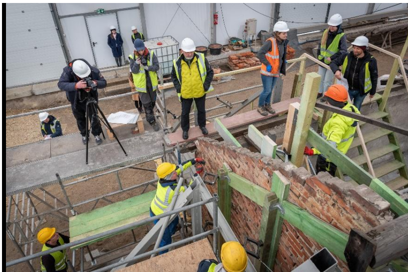
Fot. 10. B-115 – prostowanie ściany wschodniej. (fot. R. Pacek).
